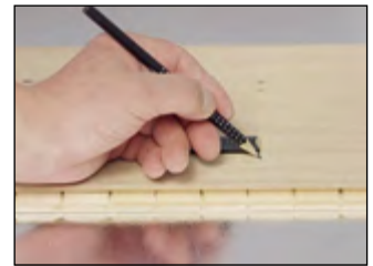
Die letzte Diele der ersten Reihe wird unter Beachtung des Wandabstands auf die notwendige Länge gekürzt. Das abgeschnittene Stück der Diele wird als Beginn der zweiten Reihe verwendet.
