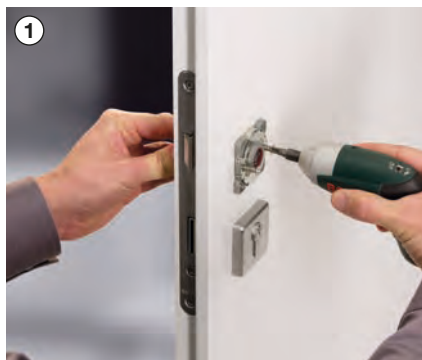
1 Unterkonstruktion aufstecken und festschrauben
